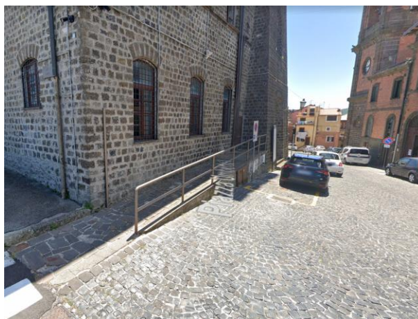
Rampa per ingresso edificio Piazza Umberto I (Rocca Priora - RM)
