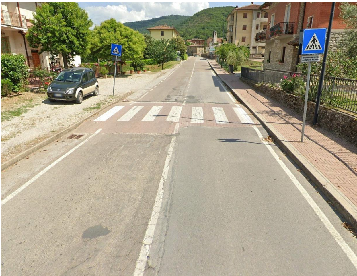
Figura 5.16 Esempio di attraversamento pedonale privo di rampe adeguate con il marciapiede. Via della Liberazione
