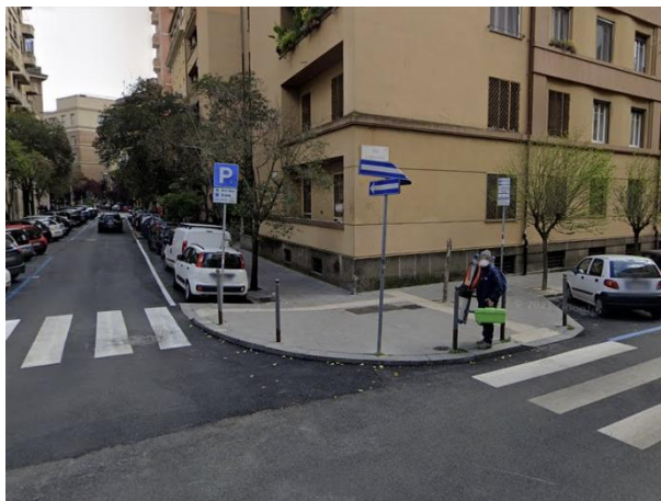
Allargamento del marciapiede – Via Reggio Calabria (Roma Capitale)
