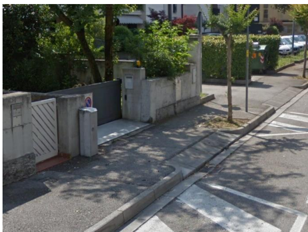
Allineamento passi carrabili alla stessa quota del marciapiede, in asfalto - Via Carli Galeotto (Sacile - PN)
